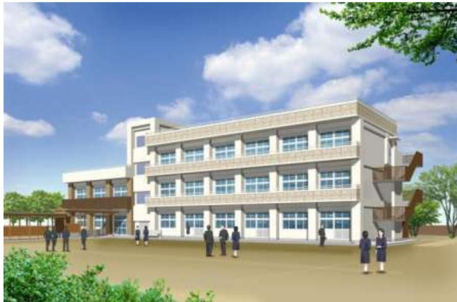
城北中学校の新築工事については、昨年6月時点で木造2階建て校舎を建設予定でしたが、津波対策として、鉄筋コンクリート造り3階建てに設計が変更されました。
