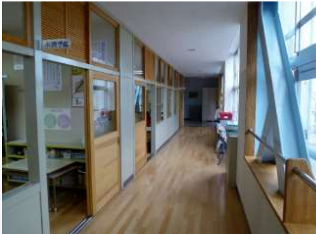
如水小の耐震、内装工事の様子
